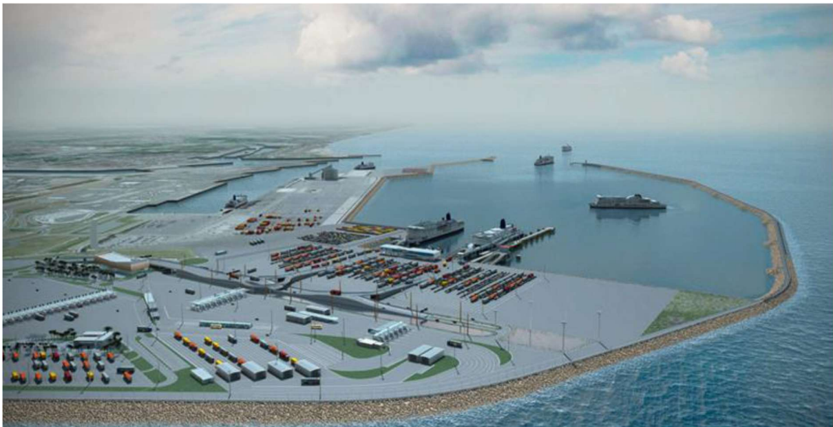
Slika 15. Port of Calais terminal (Calais, Francuska)
