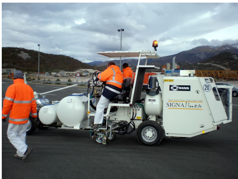
Slika 4. Stroj većeg kapaciteta za izvođenje bojanih oznaka na kolniku Izvor: [13]
