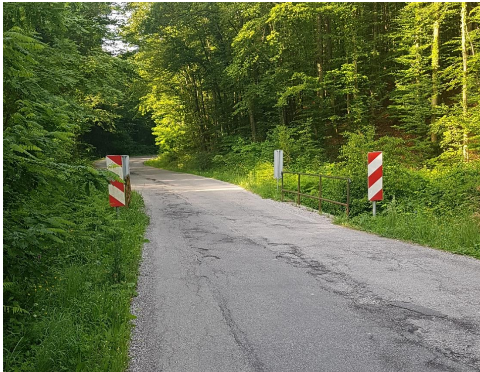
Slika 33. Trenutno stanje mosta na dionici prometnice
