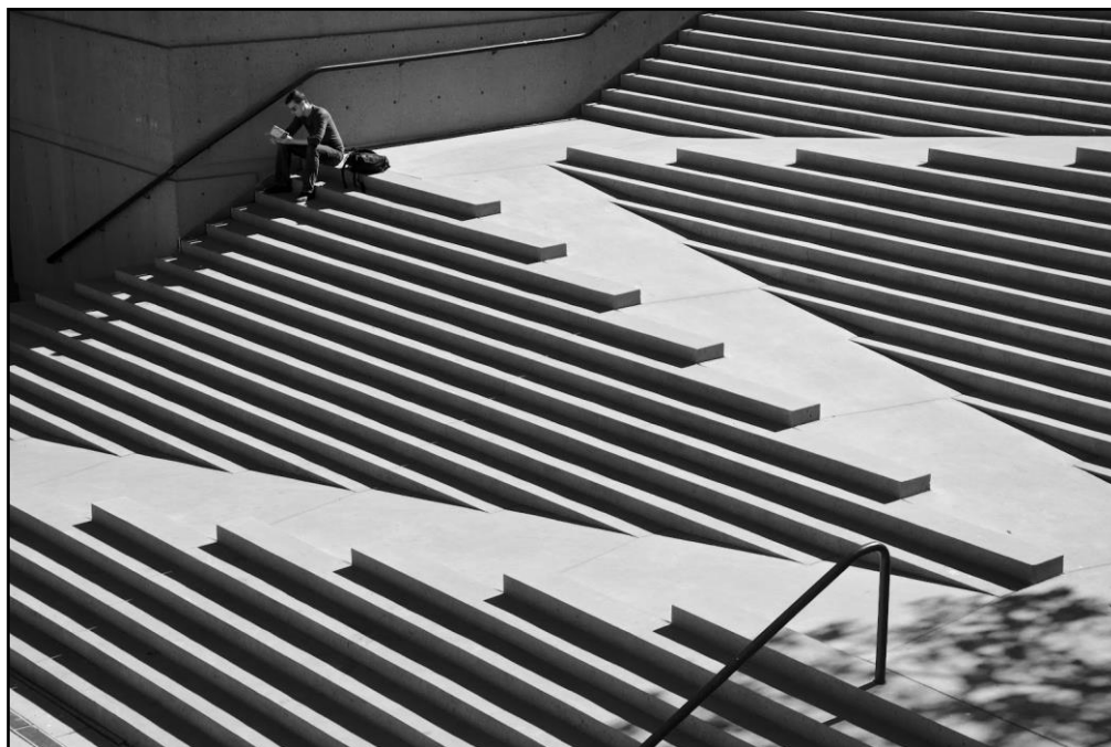
Slika 21. Kombinacija stepenica i rampe [24]
