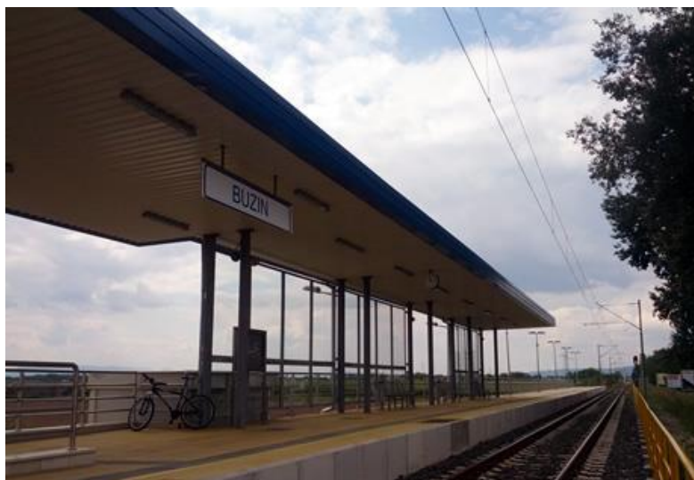
Slika 5-7 Željeznička stanica Buzin, Izvor [19]
