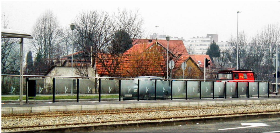
Slika 2-3 Primjer zaštitne ograde
