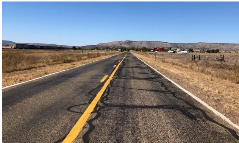
Slika 1. Primjer razdvajanja suprotnih prometnih trakova žutom punom linijom na kulturnoj američkoj cesti Route 66
