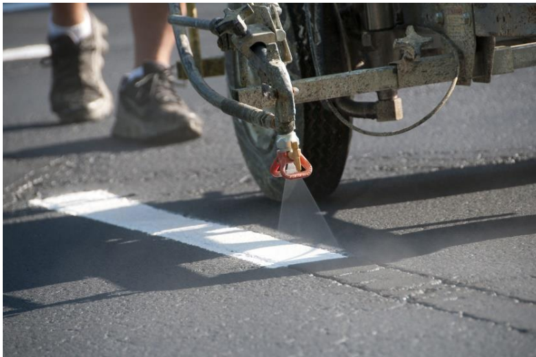
Slika 8. Označavanje parkirnih mjesta malim strojem
