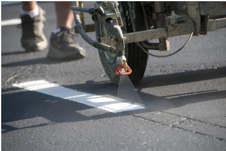
Slika 8. Označavanje parkirnih mjesta malim strojem
