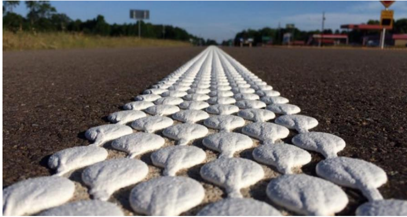
Slika 10. Primjer strukturirane oznake izrađene od termoplastike
