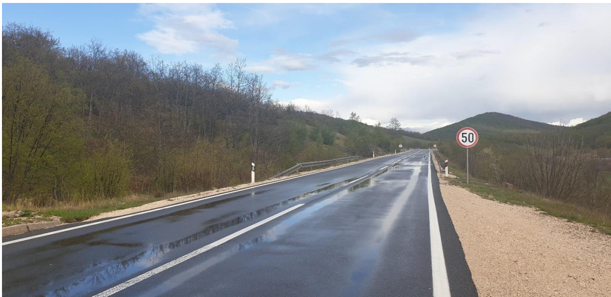
Slika 25. Lokacija 2, pogled uzduž ceste
