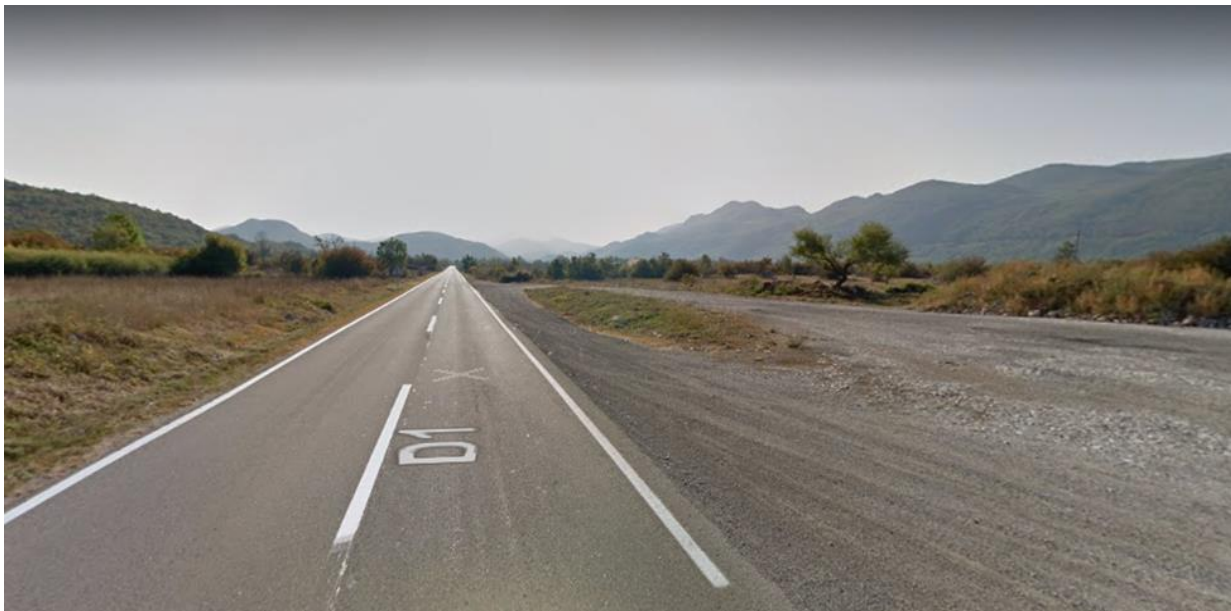
Slika 22. Lokacija 1, uzdužni pregled ceste
