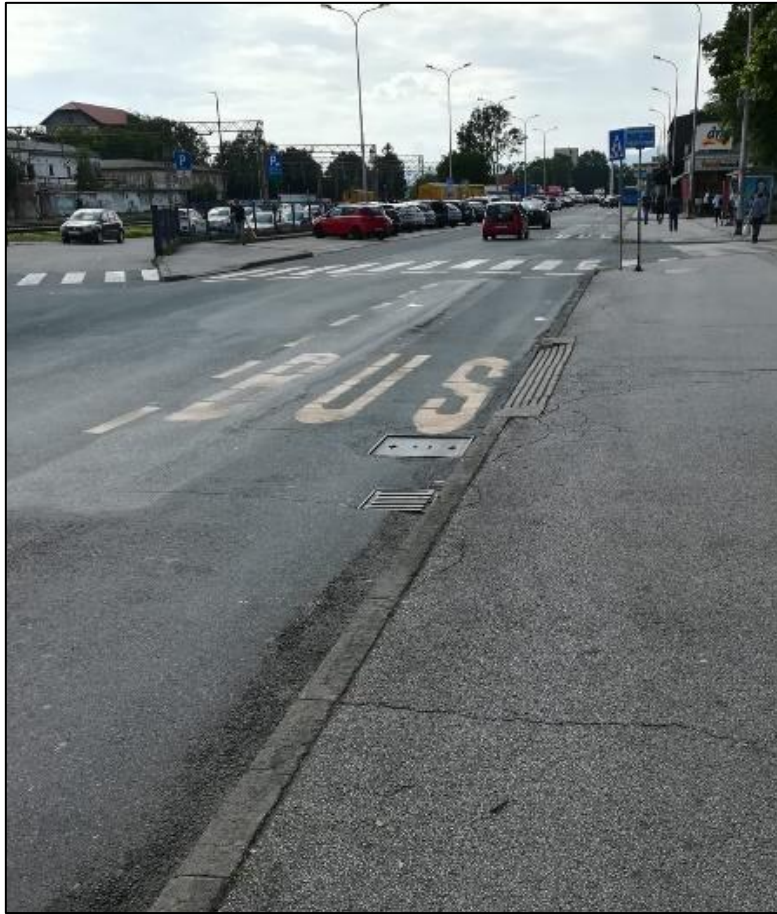
Slika 14. Slika izlazno-ulazne stanice terminala Sesvete Izvor: autor
