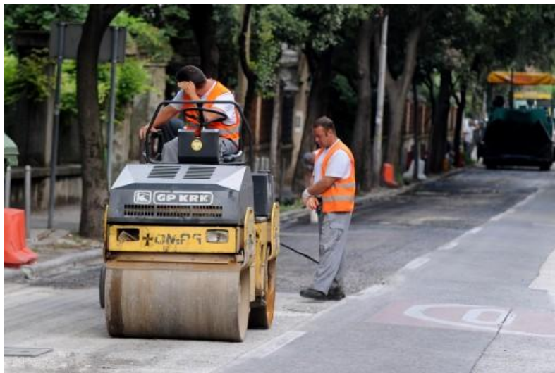
Slika 10.: Obnavljanje kolničkog zastora, [14]
