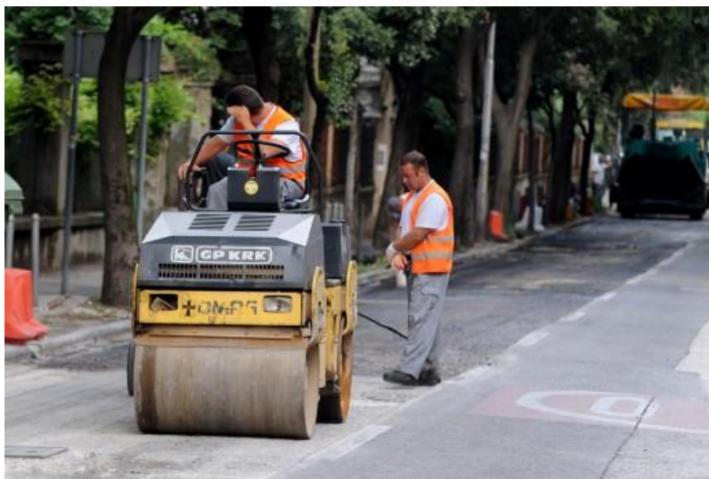
Slika 10.: Obnavljanje kolničkog zastora, [14]
