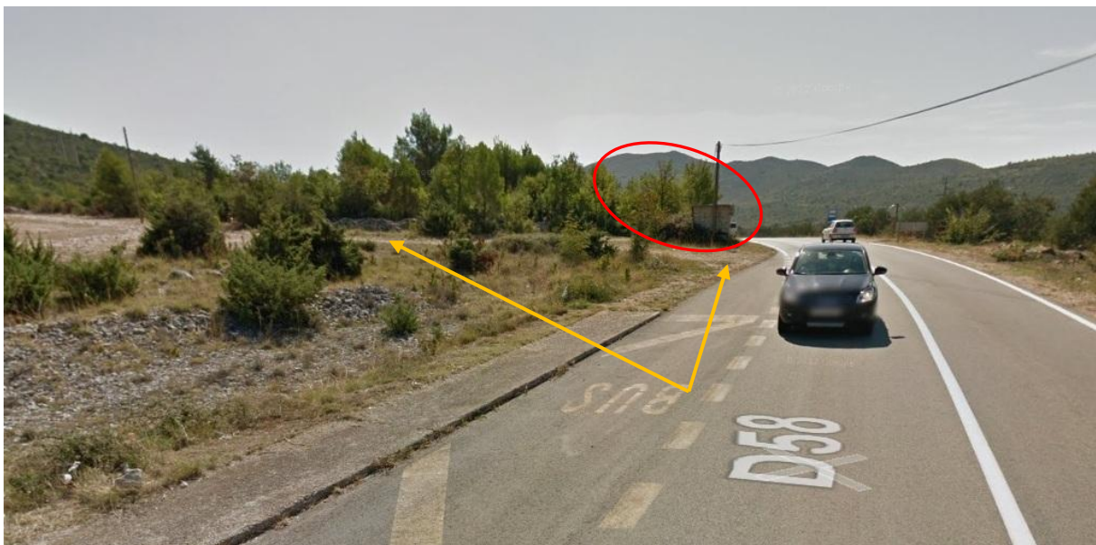
Slika 14.: Zavoj na dionici ceste D58 u Konjičkoj Dragi, [17]
