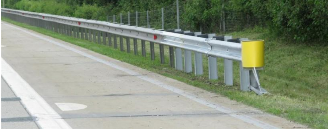
Slika 7.: Zaštitna ograda na cesti, [11]
