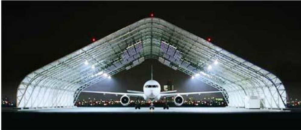
Slika 12. Sustav odleđivanja zrakoplova pomoću infracrvenog zračenja [15]
