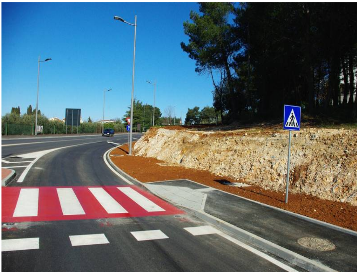
Slika 30. Izgled pješačke staze na rekonstruiranom raskrižju, [22]
