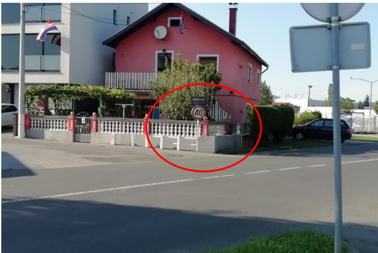
Slika 20. Prikaz potencijalno opasnog krutog elementa smještenog uz rub ceste (betonska ograda) na Raskrižju 1
