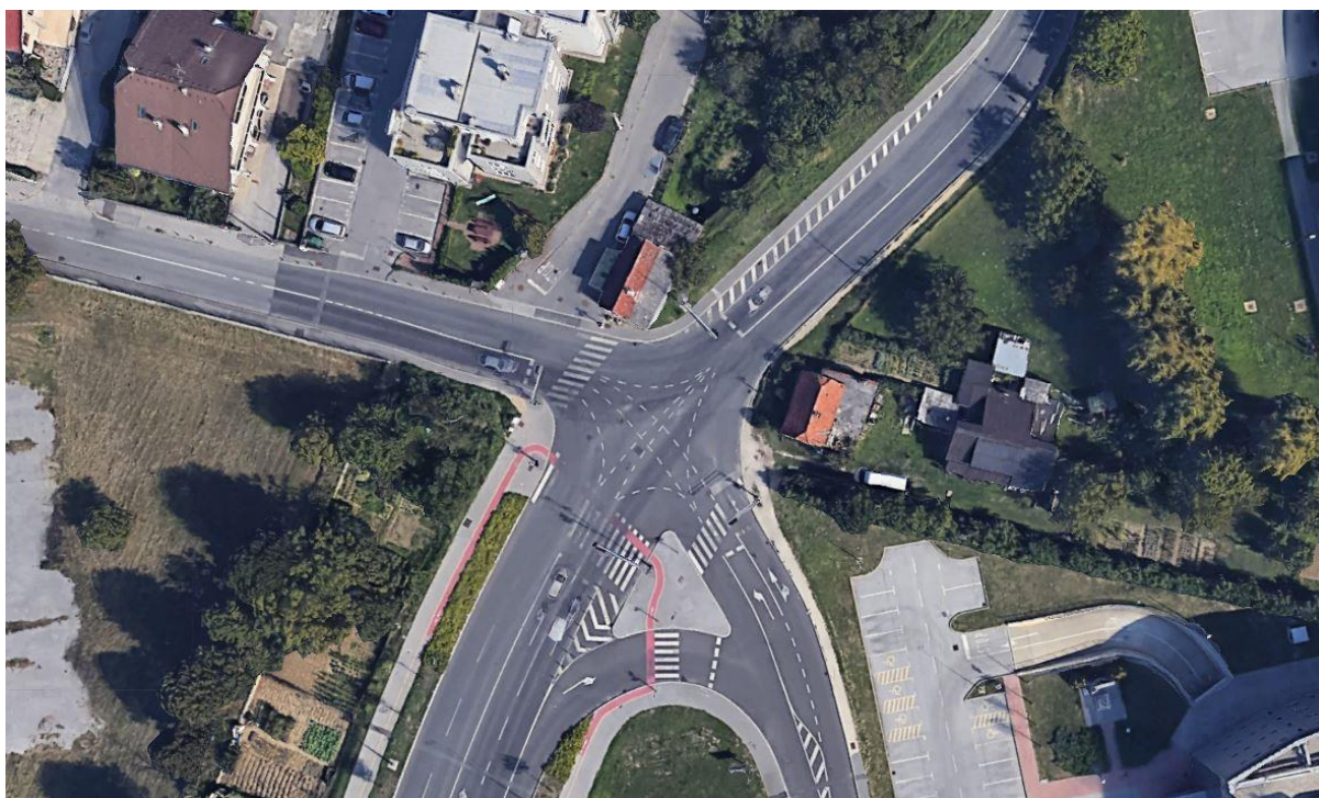
Slika 24. Raskrižje „Vukomerečka cesta - Ulica Siniše Glavaševića - Vukomerec ulica“ [10]
