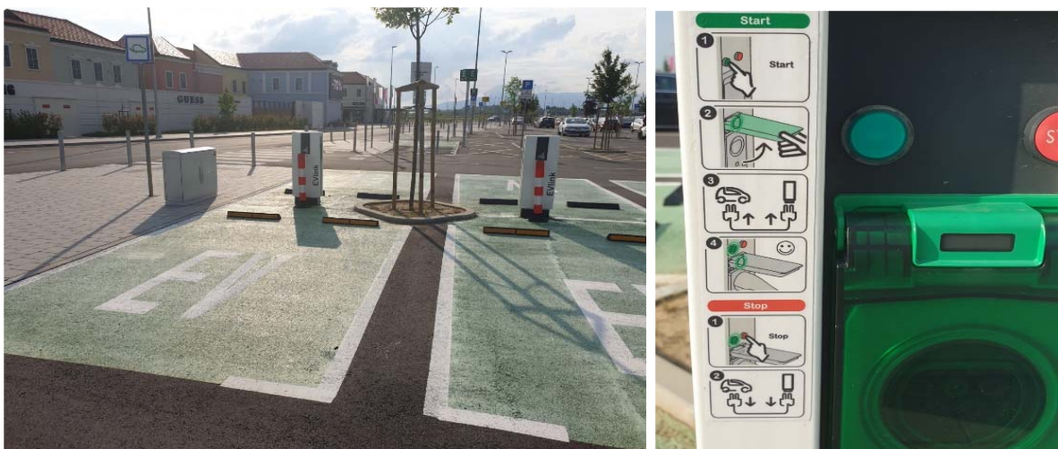
Slika 10. Punionica s izmjeničnom strujom i utičnicom tipa 2
