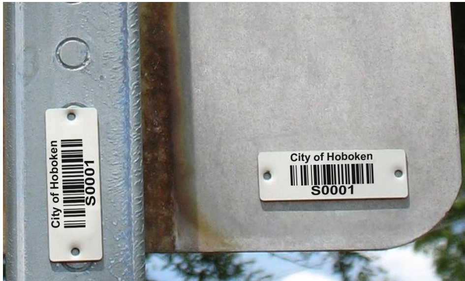
Slika 6. Primjer označavanja prometnih znakova 1D bar-kodom
