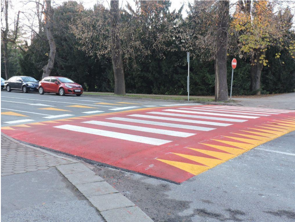
Slika 15. Primjer uzdignutog pješačkog prijelaza u Varaždinu
