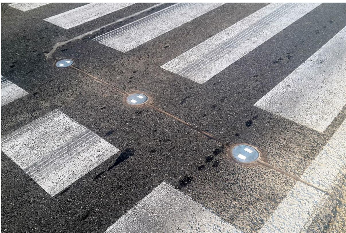
Slika 21. Primjer LED markera na pješačkom prijelazu
