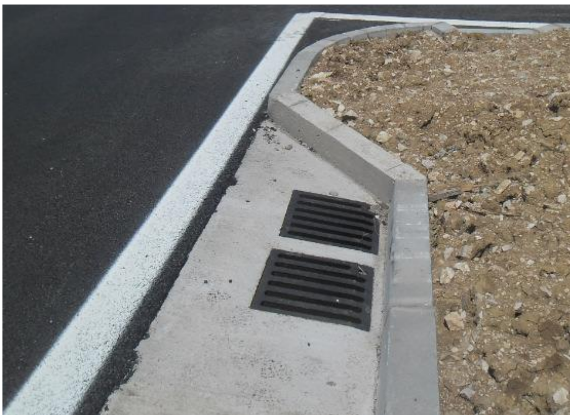
Slika 12. Učinkovito prikupljanje oborinske odvodnje
