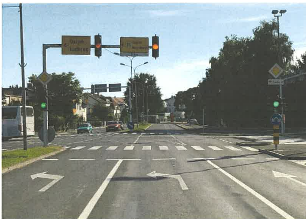
Slika 22. Neusklađenost semafora na sjevernom privozu
