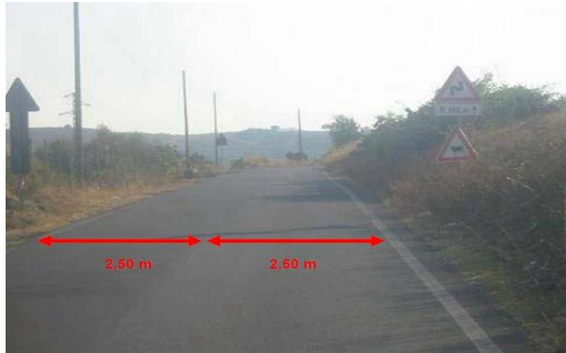
Slika 11. Širina prometne trake na državnim cestama manja od 2,75 m
