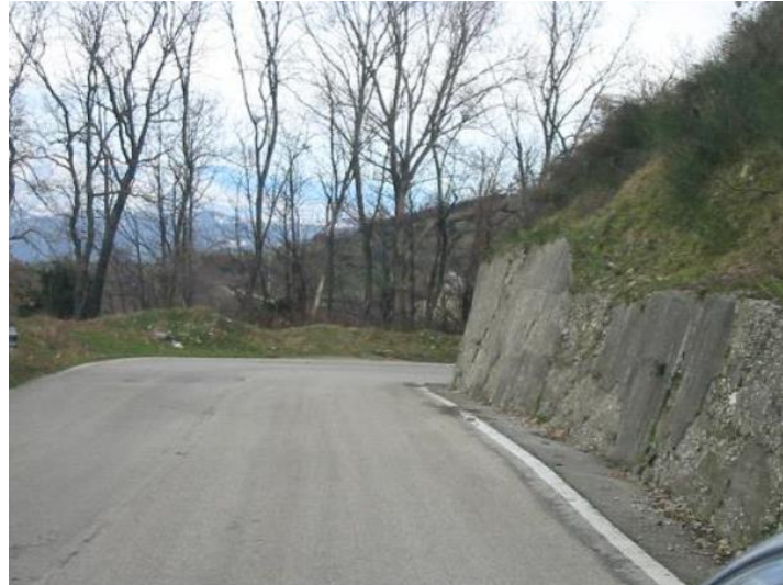
Slika 7. Nedostatak ploča za označavanje oštrog zavoja
