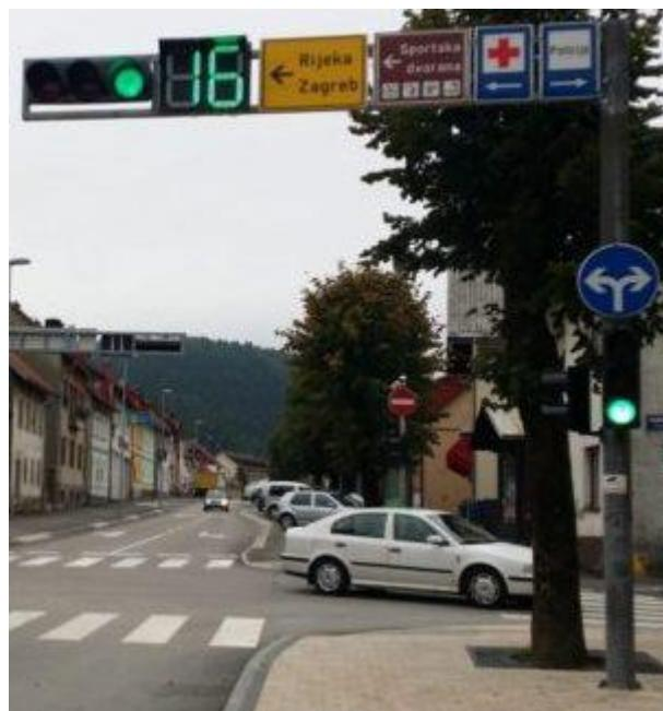
Slika 6.41: Brojač vremena na semaforskem uređaju
