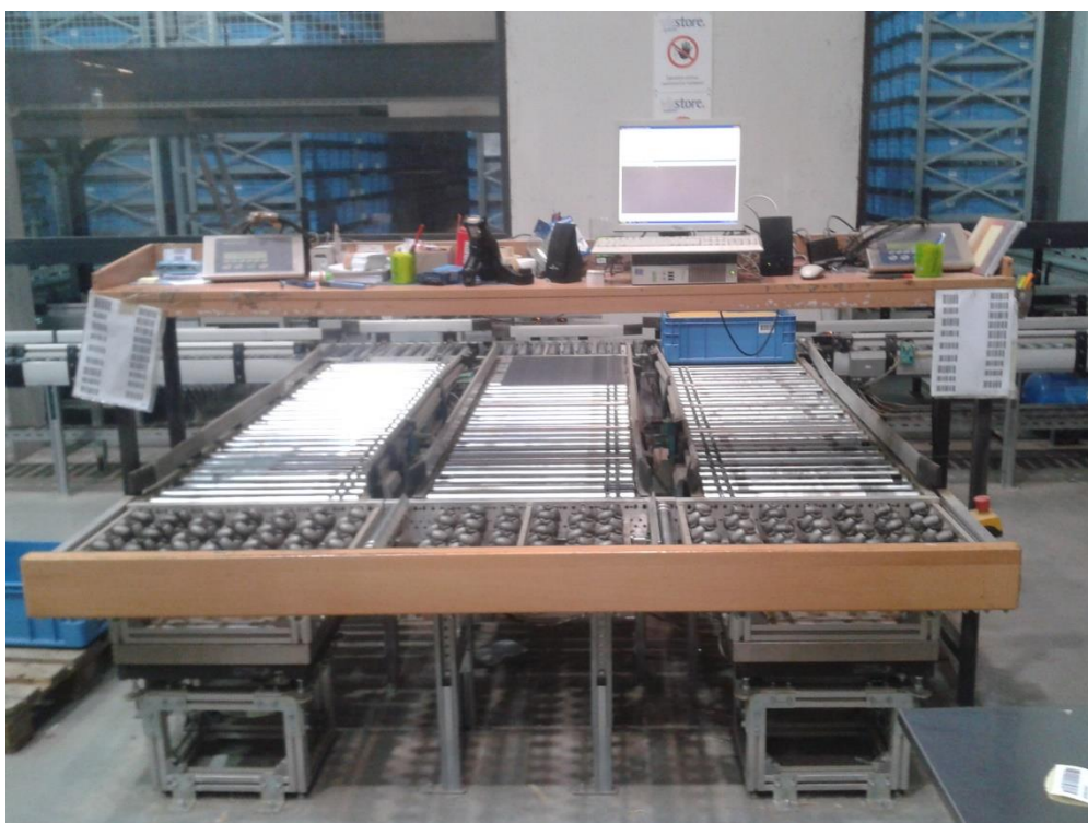
Slika 9. Upravljački pult robotiziranog skladišta
