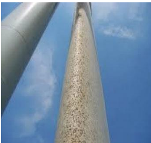
Slika 32. Prljavština, kukci i ptičji izmeti na lopaticama
