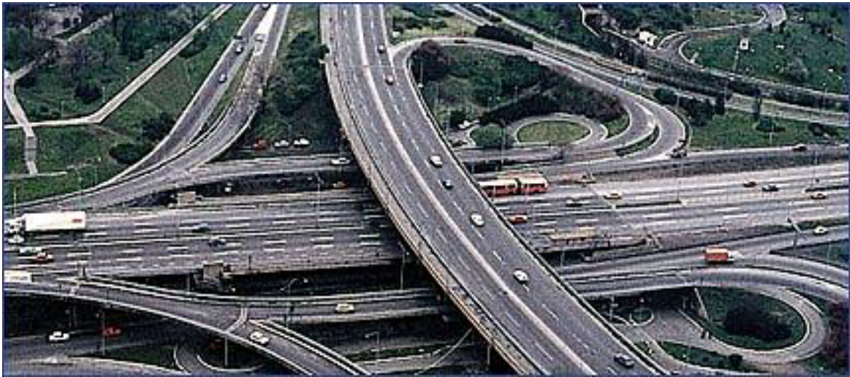
Slika 5: Raskrižje izvan razine na primjeru Mostarske petlje, Beograd, Republika Srbija [9]
