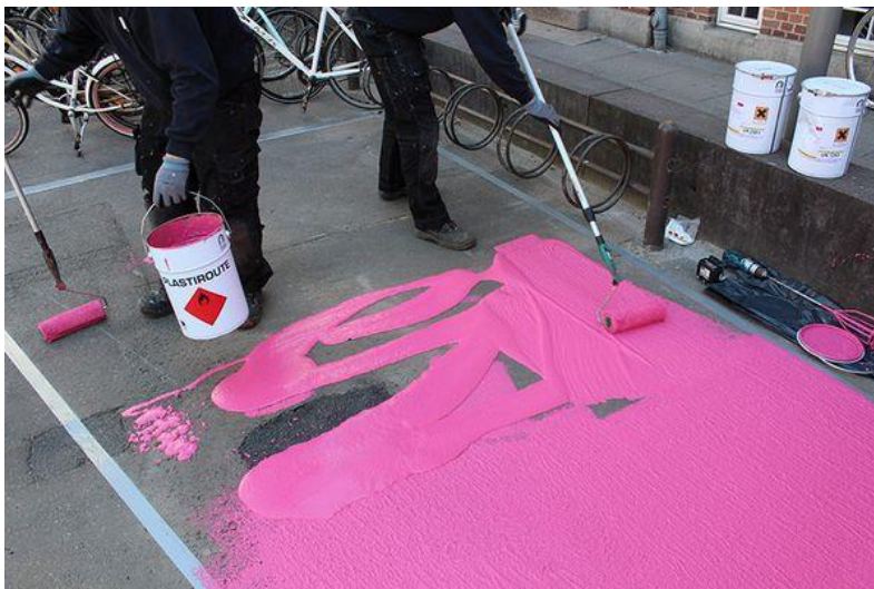
Slika 7. Ručno postavljanje hladne plastike
