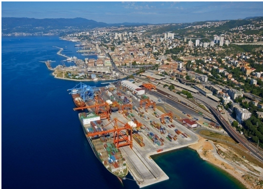
Slika 4. Kontejnerski terminal Jadranska vrata
