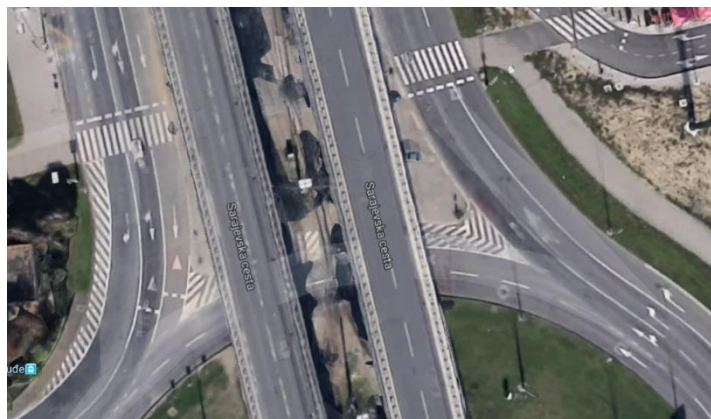
Slika 44. Sjeverni dio kružnog toka Zapruđe Izvor: [11]
