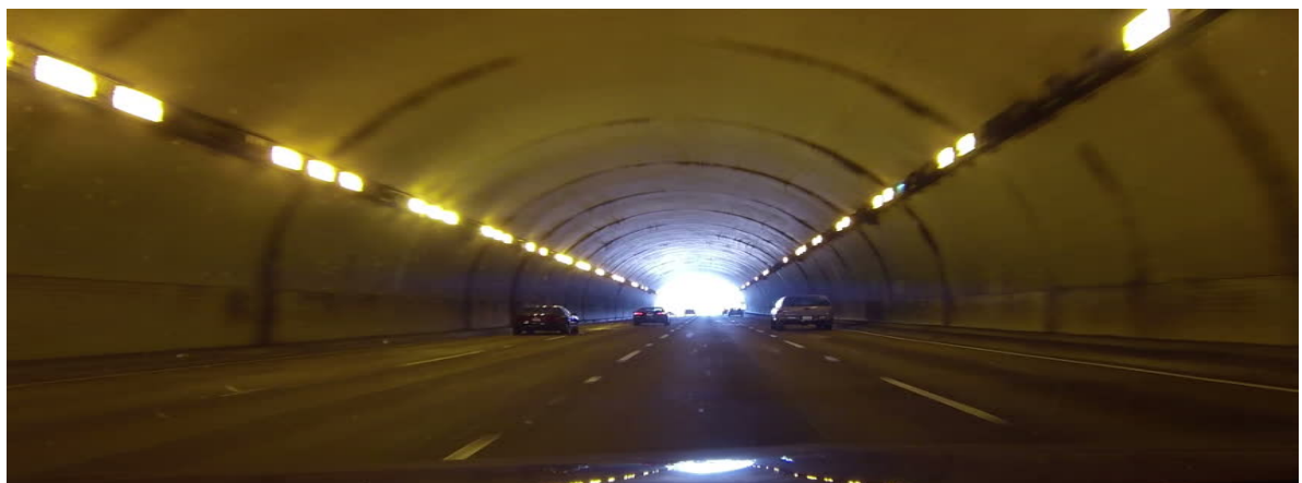
Slika 9. Zasljepljenje pri izlasku iz tunela [9]
