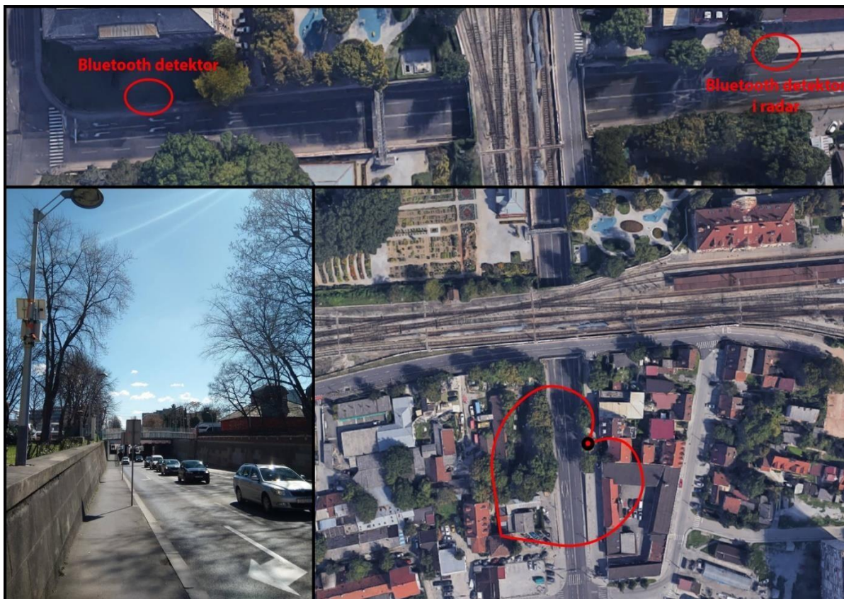
Slika 8. Lokacija i usmjerenost jednog usmjerenog Bluetooth detektora
