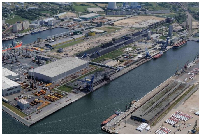
Slika 25. Primjer skladišta terminala za kruti rasuti teret
