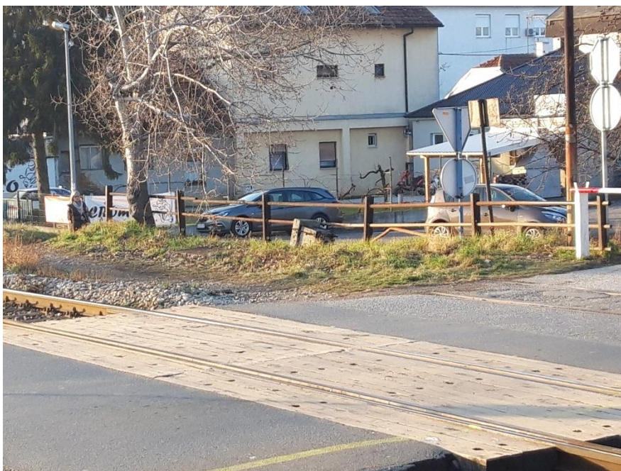
Slika 15. Postojeća zaštitna ograda duž Stipanovićeve ulice
