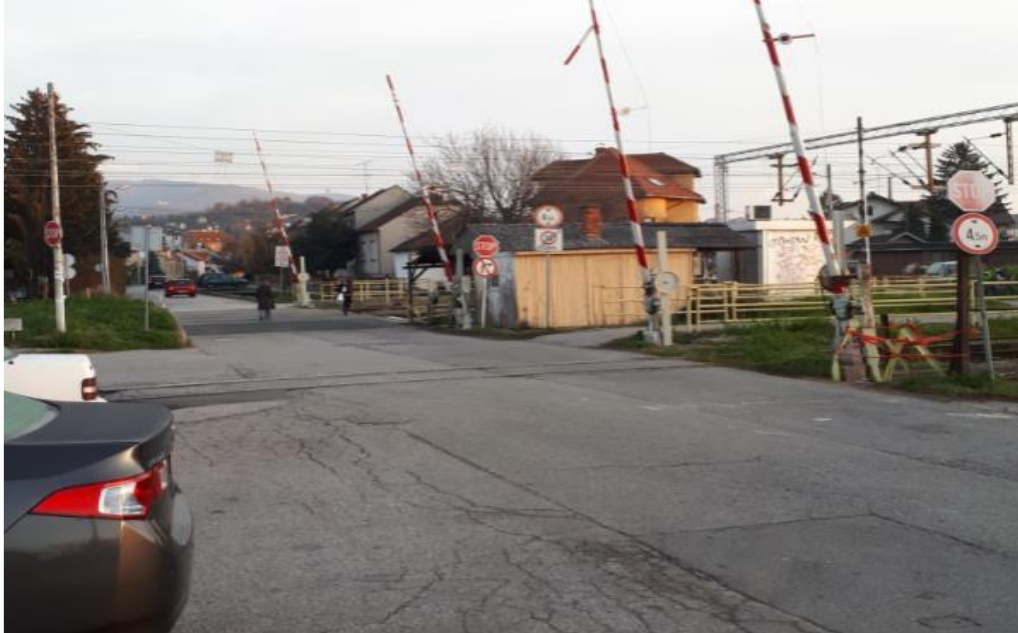
Slika 6. Postojeće stanje na ŽCP-u Sokolska
