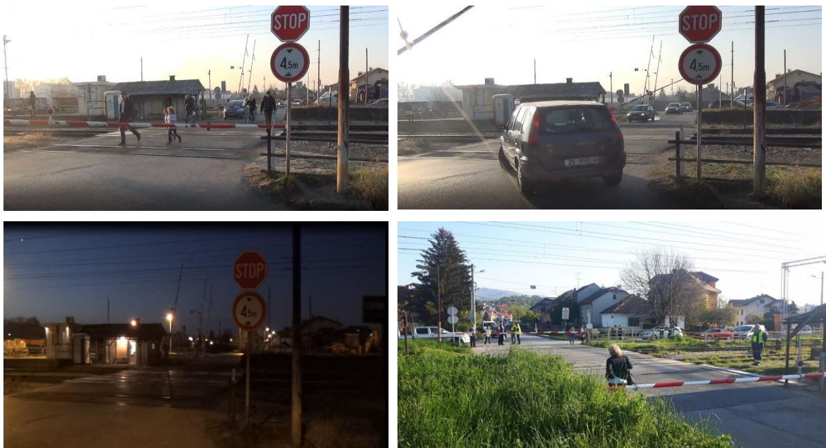
Slika 5. Izgled i način osiguranja ŽCP-a Sokolska
