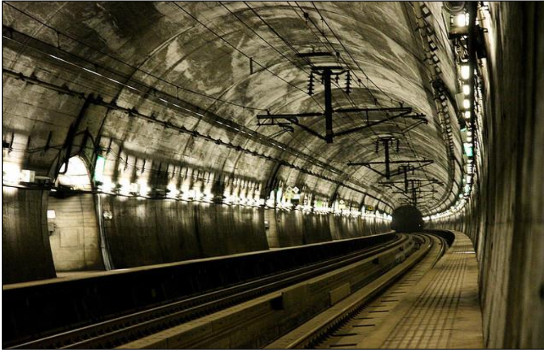
Slika 13. Unutrašnjost tunela Seikan
