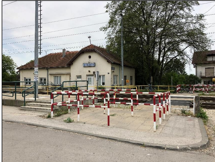
Slika 4. Križanje željezničke pruge i pješačke staze u istoj razini
