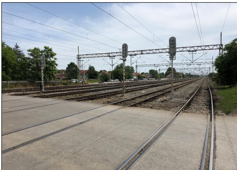
Slika 32. Pogled sa ŽCP-a „B2” prema kolodvorskoj zgradi
