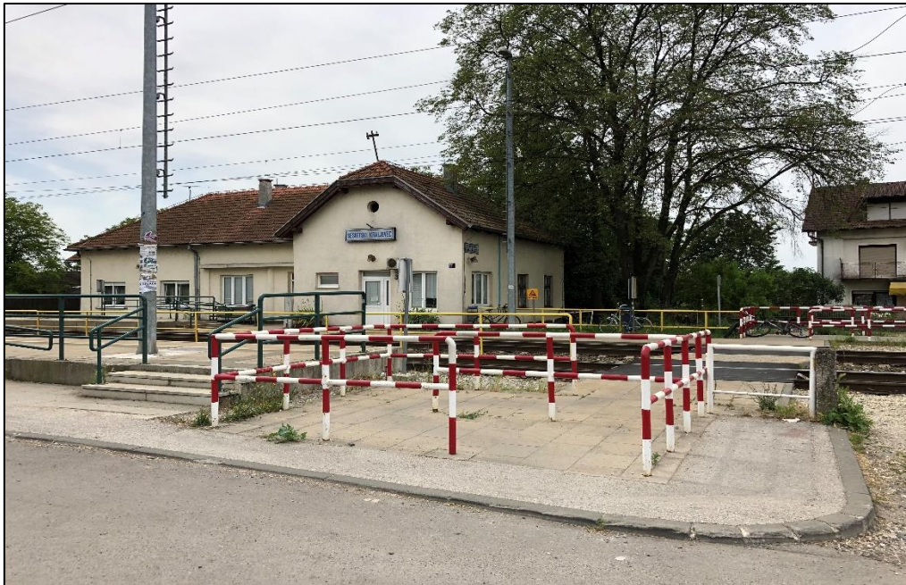
Slika 25. Pješački prijelaz na stajalištu Sesevski Krajevec
