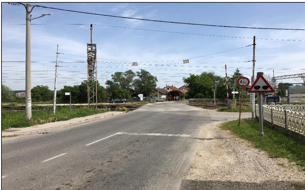
Slika 30. Pogled na ŽCP „B2“ u smjeru sjevera
