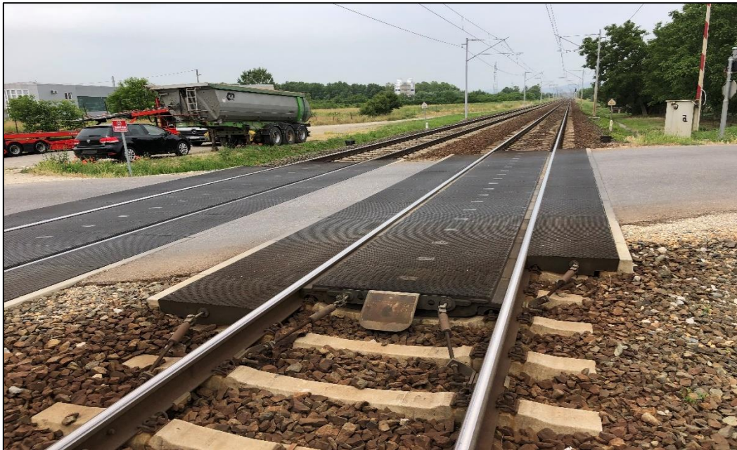
Slika 21. Modularno sintetička podloga „Strail“, pogled u smjeru Sesveta
