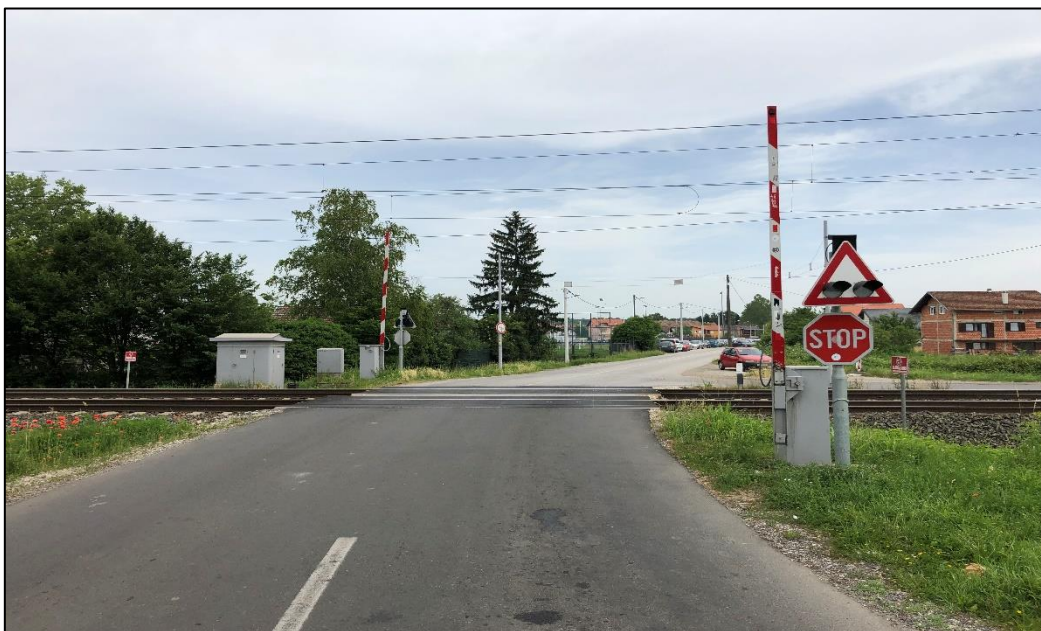
Slika 23. Pogled na ŽCP „Rade Končar“ u smjeru sjevera
