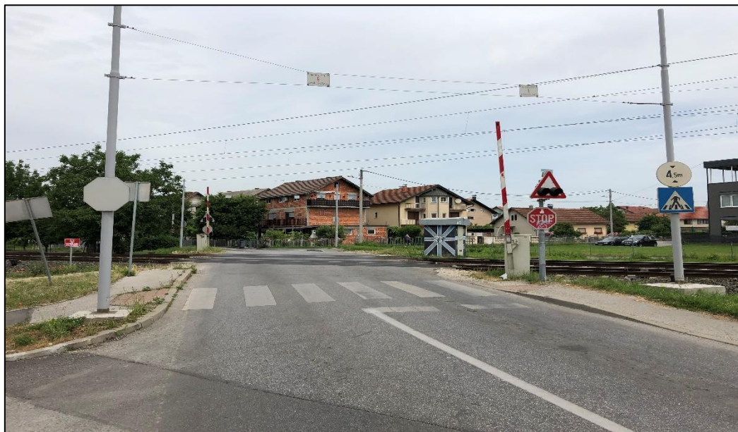
Slika 20. Željezničko-cestovni prijelaz „Sesvetska Selnica“ – pogled prema sjeveru
