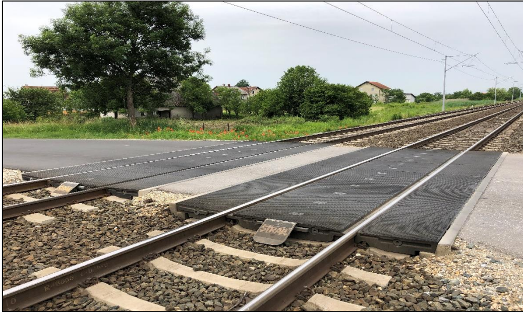
Slika 24. Podloga na ŽCP-u „Rade Končar“, pogled u smjeru Seseveta
