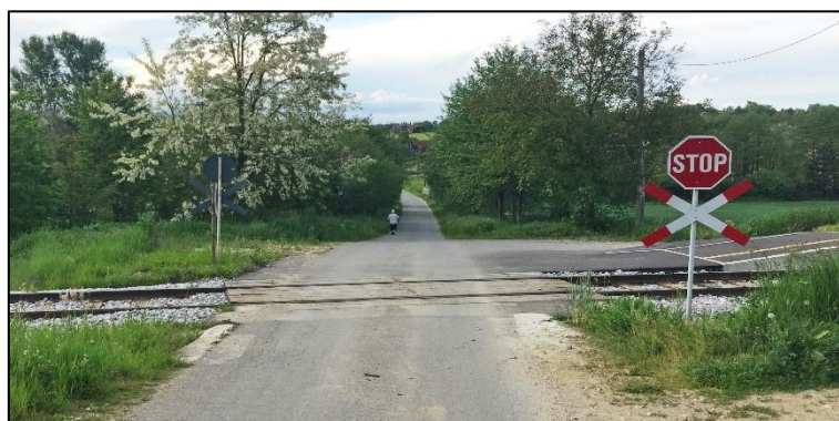
Slika 7. Pasivno osiguran željezničko-cestovni prijelaz
