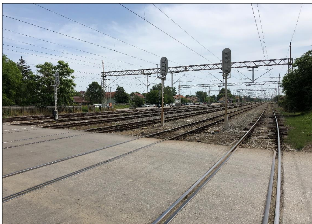
Slika 32. Pogled sa ŽCP-a „B2" prema kolodvorskoj zgradi
