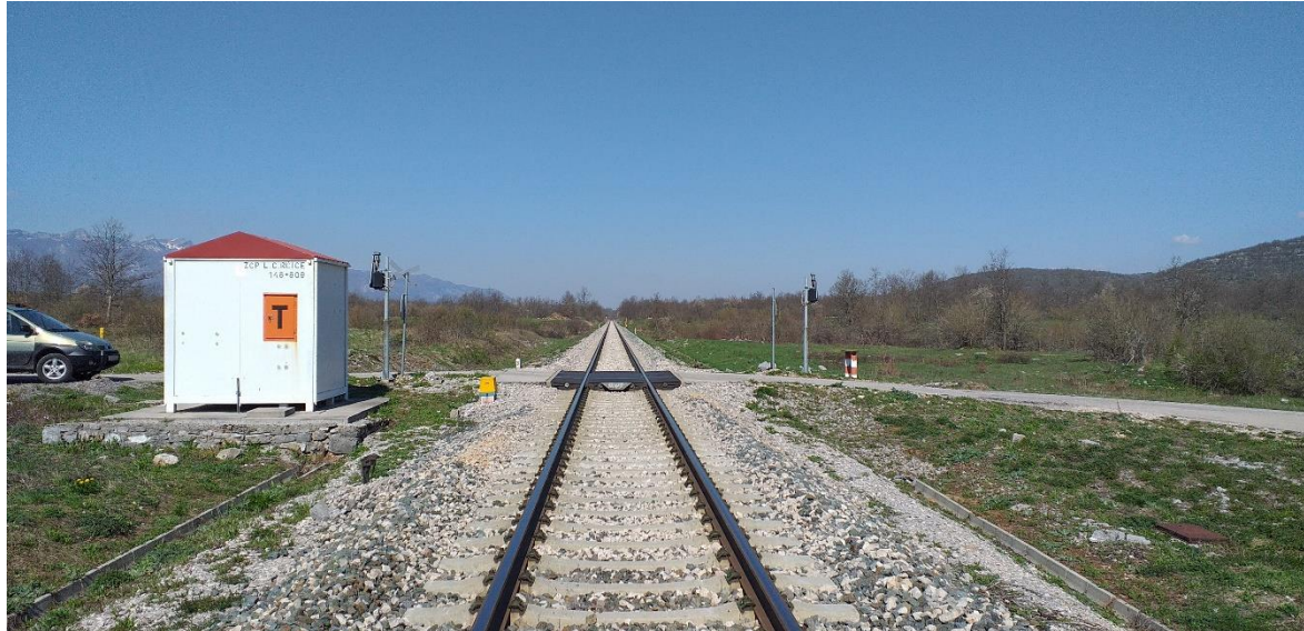
Slika 34. Kućica sa uređajem ŽCP-a ometa preglednost na prugu
