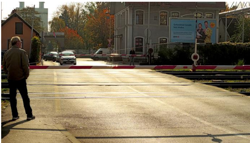
Slika 12. Primjer aktivnog osiguranja željezničko-cestovnog prijelaza sa banicima
