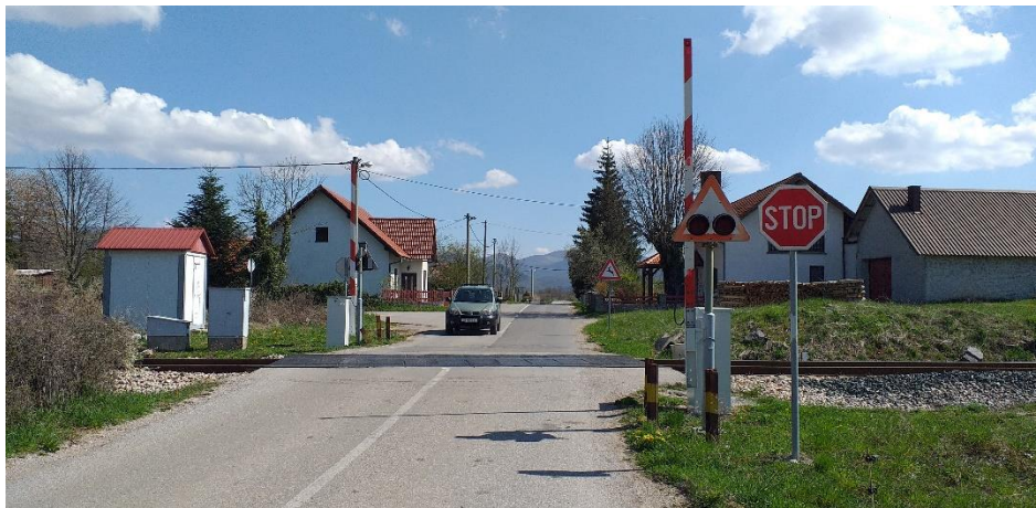
Slika 3. Primjer željezničko-cestovnog prijelaza u istoj razini
