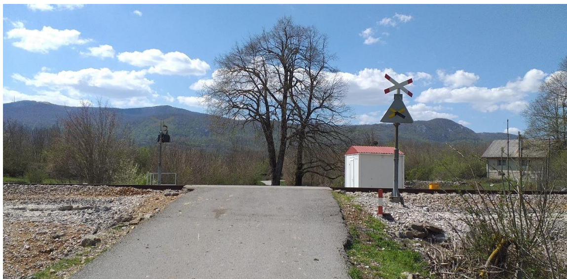
Slika 45. Željezničko-cestovni prijelaz Štikada iz smjera sjevera
