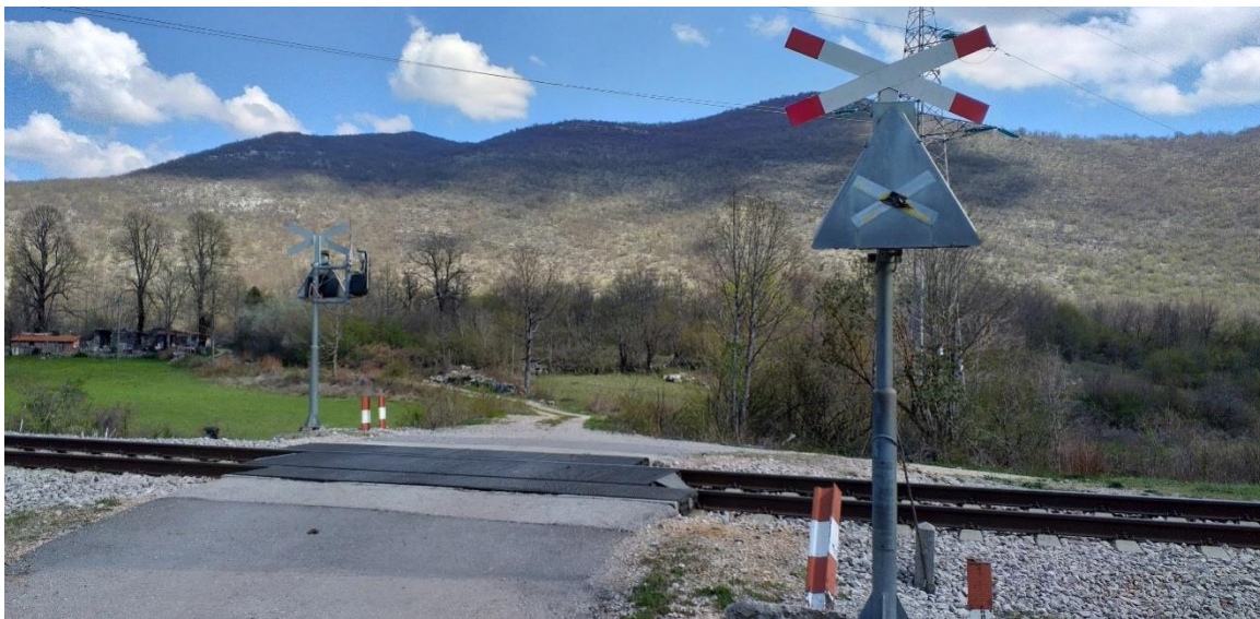
Slika 37. Željezničko-cestovni prijelaz Ričice 2 iz smjera juga
