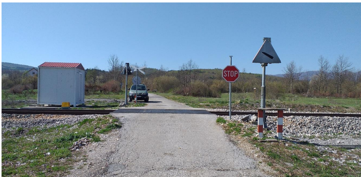
Slika 31. Željezničko-cestovni prijelaz Ričice iz smjera sjevera
