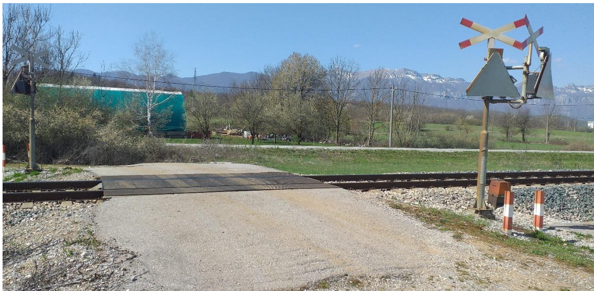
Slika 22. Željezničko-cestovni prijelaz Lovinac 3 iz smjera sjevera
