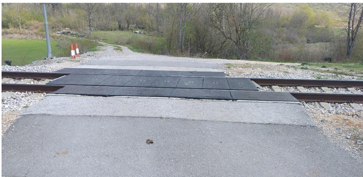
Slika 38. Prikaz izvedbe podloge na ŽCP-u Ričice 2
