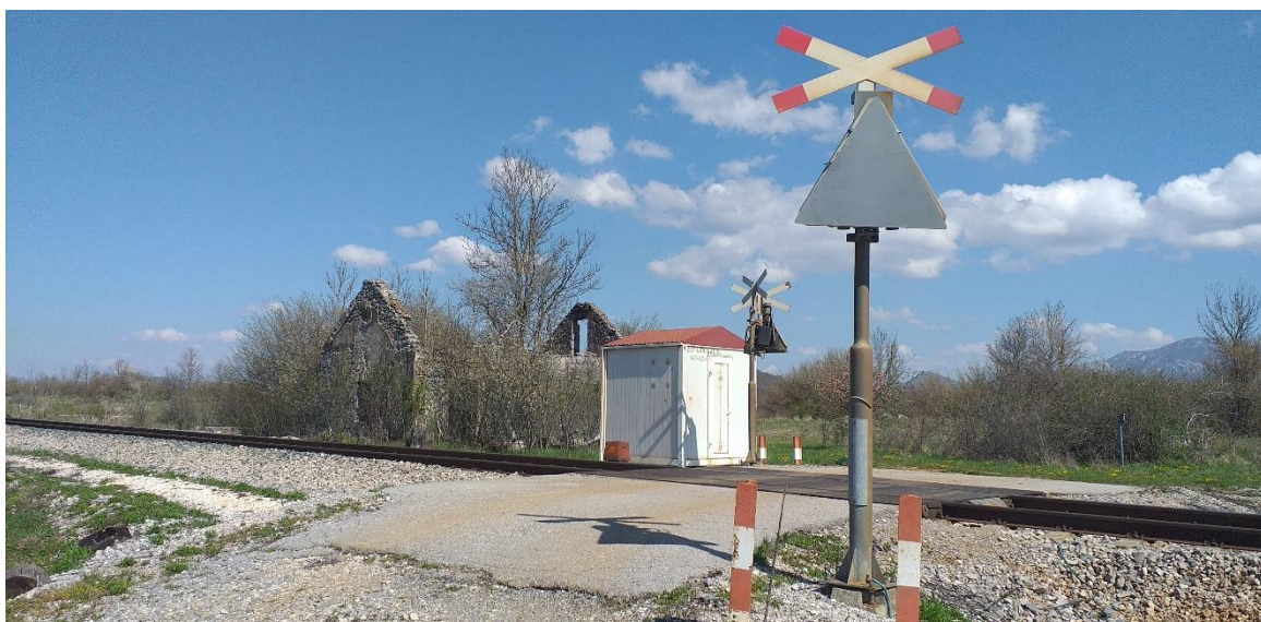
Slika 23. Željezničko-cestovni prijelaz Lovinac 3 iz smjera juga
