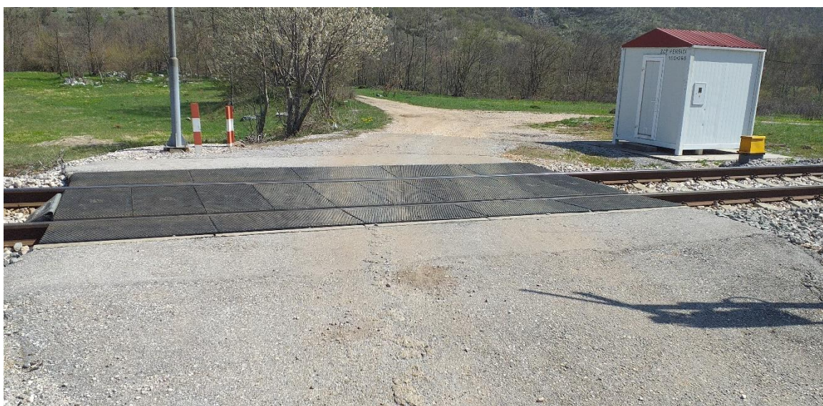
Slika 36. Prikaz podloge na ŽCP-u Peršići
