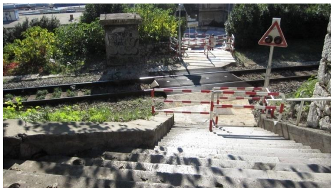
Slika 16. Pješački prijelaz sa mimoilaznim ogradama i svjetlosno-zvučnim signalima
