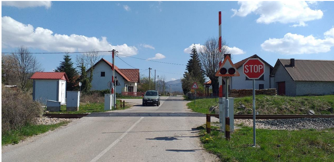
Slika 20. Željezničko-cestovni prijelaz Lovinac-kolodvor iz smjera juga
