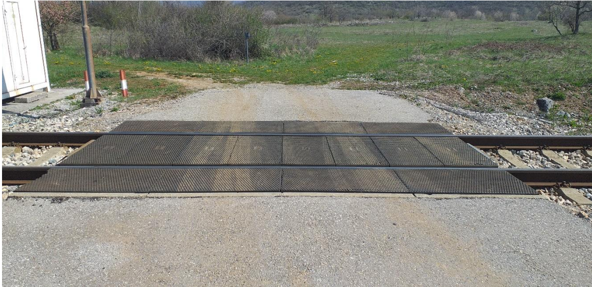
Slika 24. Prikaz podloge na željezničko-cestovnom prijelazu Lovinac 3
