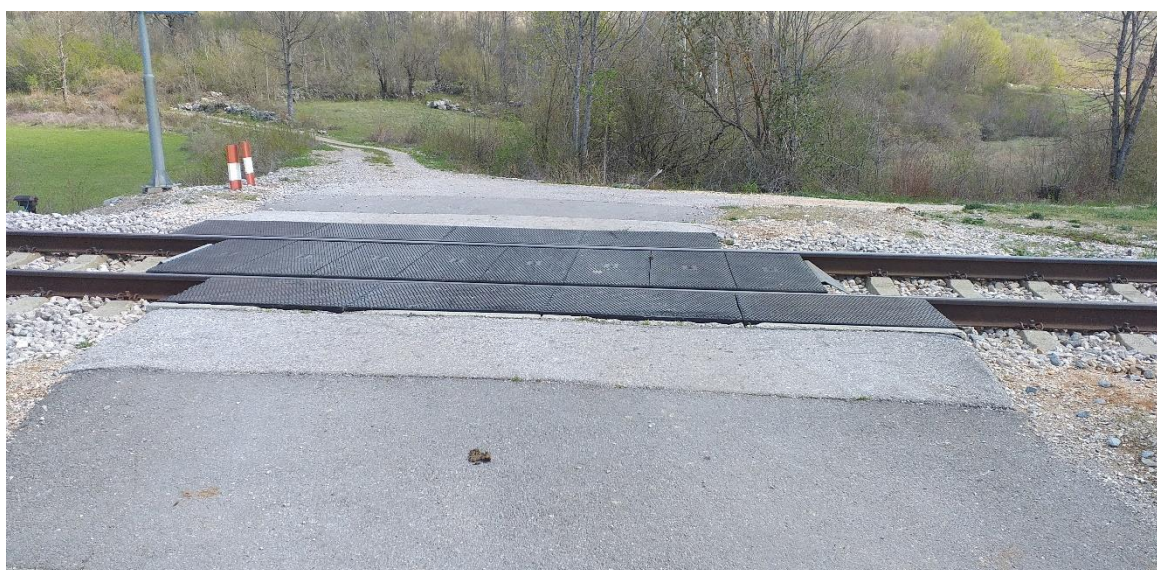
Slika 38. Prikaz izvedbe podloge na ŽCP-u Ričice 2
