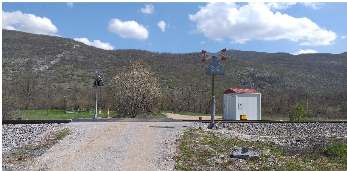
Slika 35. Željezničko-cestovni prijelaz Peršići iz smjera juga
