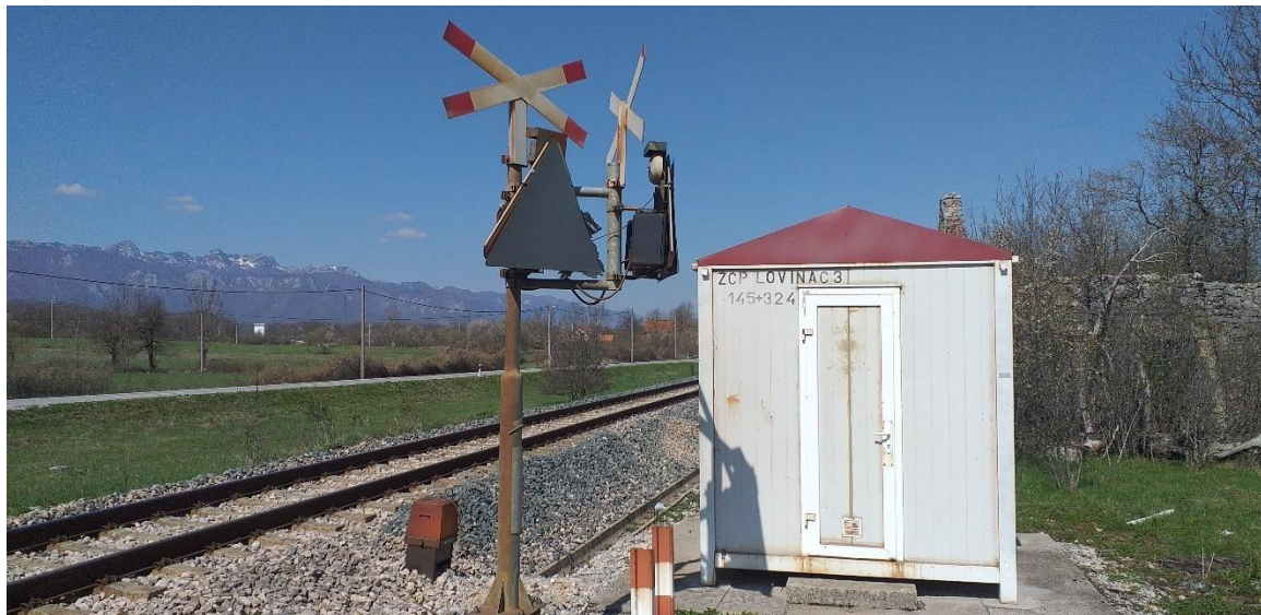
Slika 25. Otežana preglednost na prugu iz smjera sjevera
