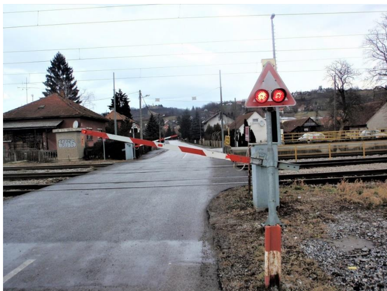
Slika 13. Primjer osiguranja željezničko-cestovno prijelaza svjetlosno-zvučnim signalima i polubranicama Izvor: http://www.zeleznice.in.rs:8080/forum/viewtopic.php?t=634&start=140 (03.05.2019.)
