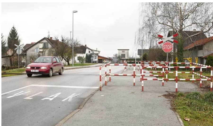
Slika 9. Primjer pasivnog osiguranja pješačkog prijelaza
