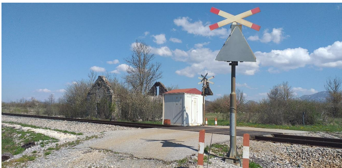
Slika 23. Željezničko-cestovni prijelaz Lovinac 3 iz smjera juga
