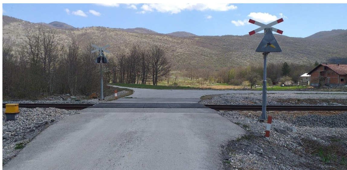
Slika 40. Željezničko-cestovni prijelaz Ričice 3 iz smjera juga
