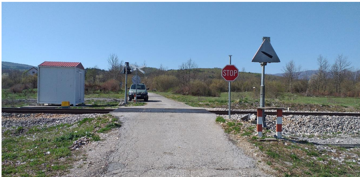
Slika 31. Željezničko-cestovni prijelaz Ričice iz smjera sjevera
