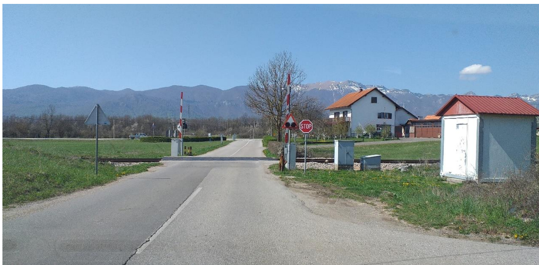
Slika 19. Željezničko-cestovni prijelaz Lovinac-kolodvor iz smjera sjevera
