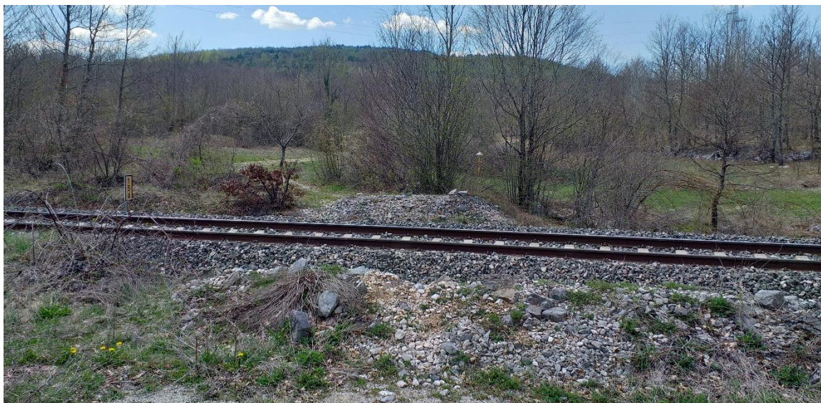
Slika 41. Prikaz ukinutog željezničko-cestovnog prijelaza
