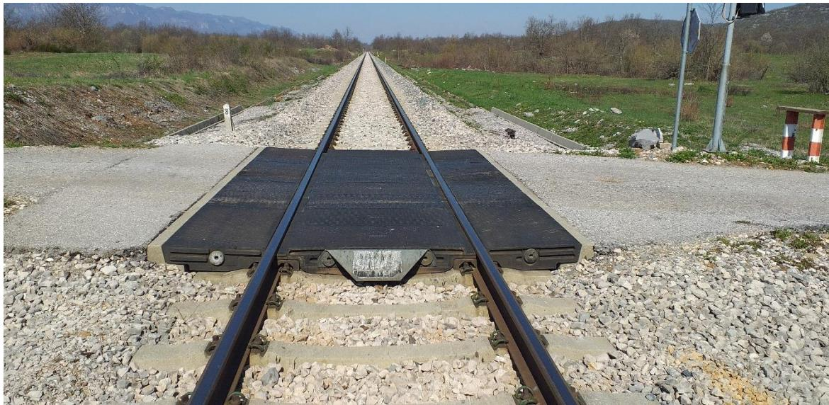
**Slika 33.** Podloga tvrtke „STRAIL“ na ŽCP-u Ričice
