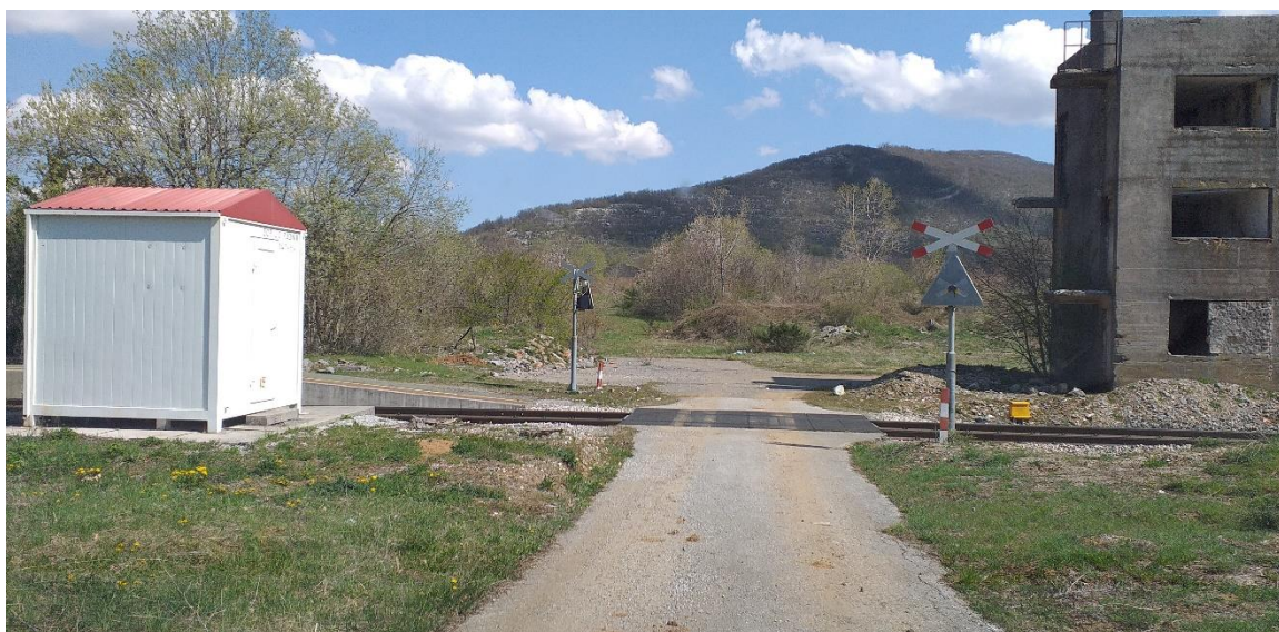
Slika 29. Željezničko-cestovni prijelaz Ličko Cerje-rudnik iz smjera juga
