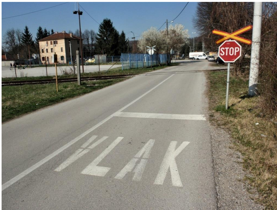
Slika 5. Primjer pasivnog načina osiguranja željezničko-cestovnog prijelaza Izvor: http://www.zeleznice.in.rs:8080/forum/viewtopic.php?t=634&start=140 (03.05.2019.)
