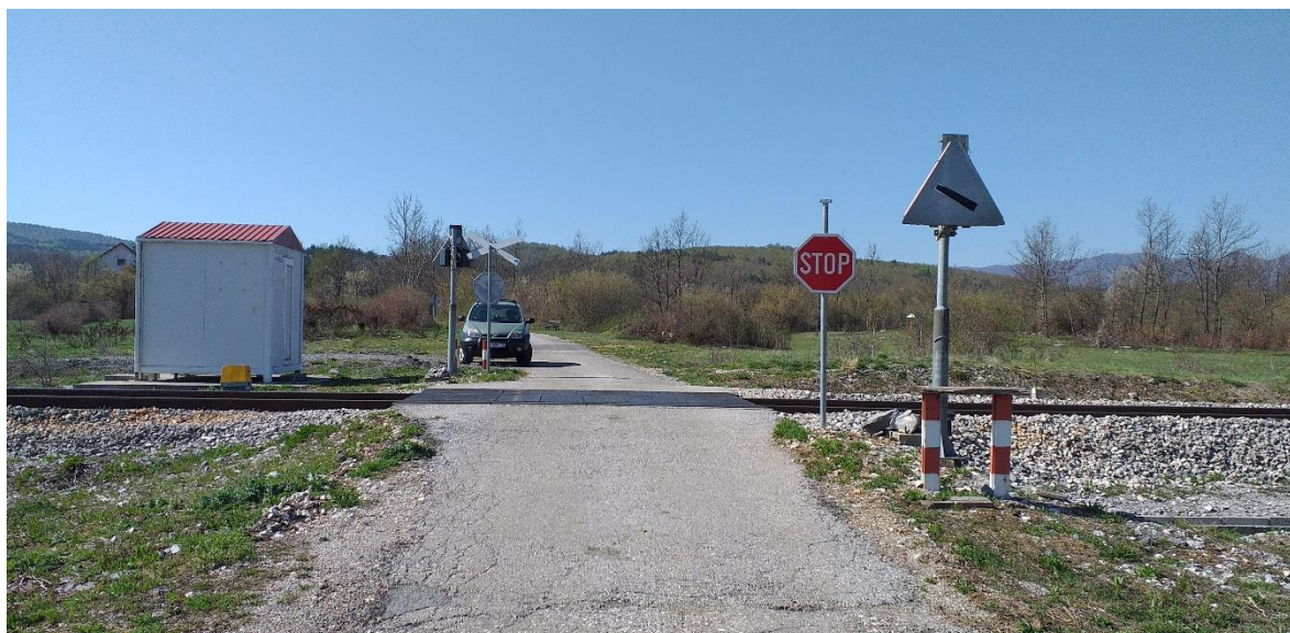
Slika 31. Željezničko-cestovni prijelaz Ričice iz smjera sjevera
