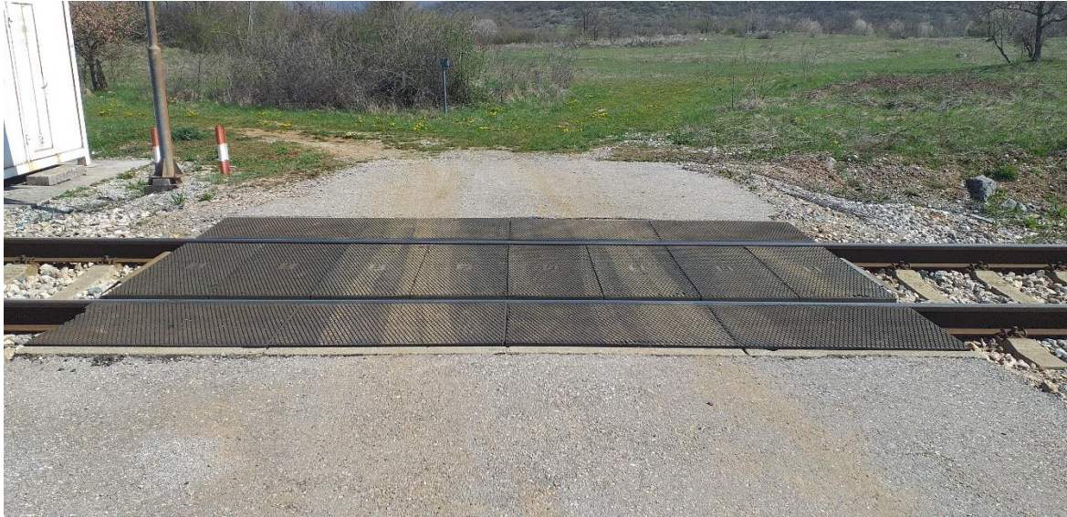
Slika 24. Prikaz podloge na željezničko-cestovnom prijelazu Lovinac 3
