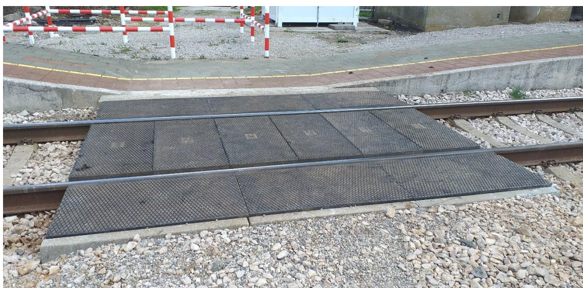
Slika 44. Prikaz podloge tvrtke „STRAIL“ na pješačkom prijelazu Štikada
