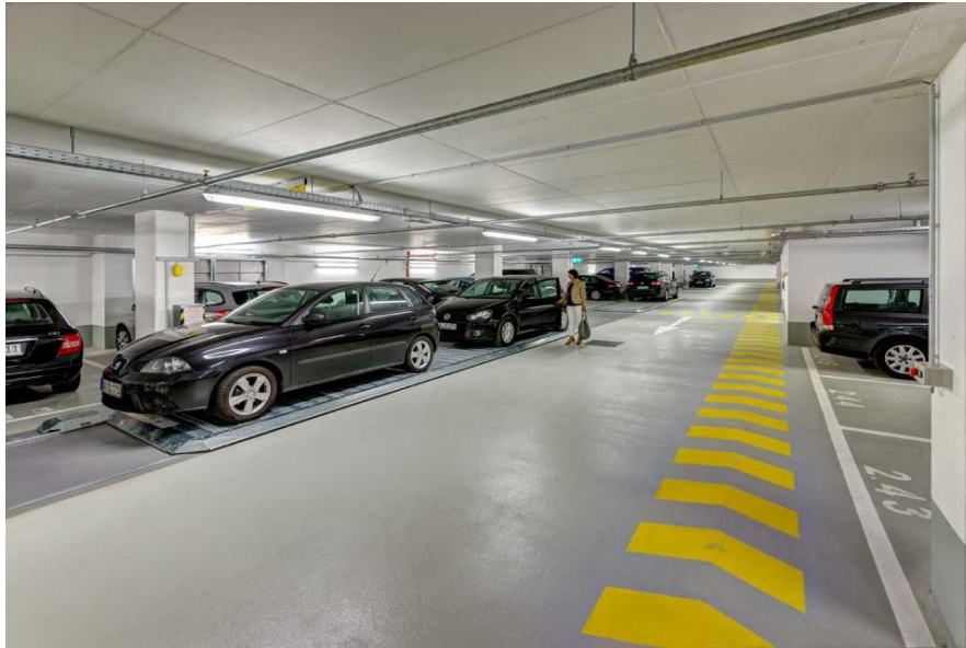
Slika 21. Potpuno mehanizirana garaža s horizontalnom platformom; [9]
