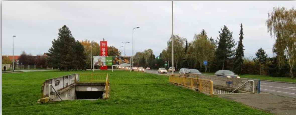
Slika 7. Pothodnik za pješake na stanici Mlinar
