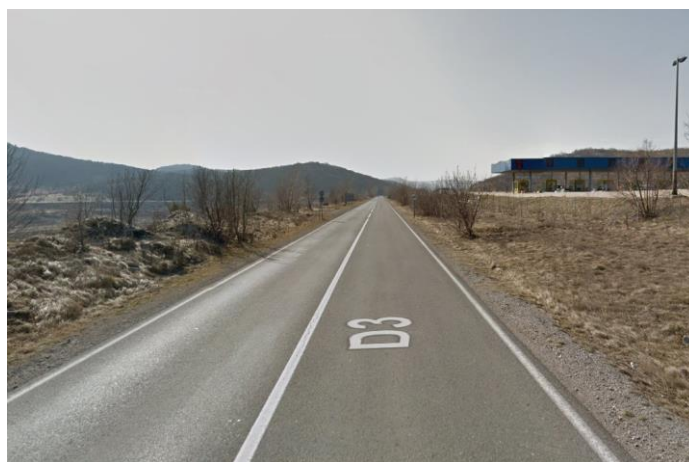
Slika 18. Postojeće stanje na dionici (18) Soboli: Čvor Kikovica (A6) - Čavle (D40), stacionaža (0,033 - 0,307) - smjer Čavle, Izvor: https://www.google.hr/maps/ , rujan 2018.
