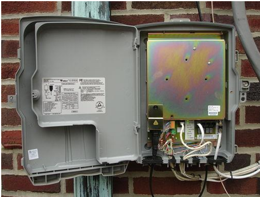
Slika 12. Optički mrežni terminal, [22]
