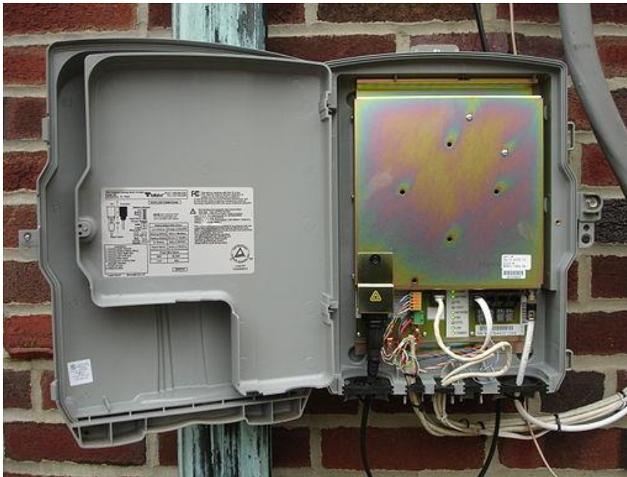
Slika 12. Optički mrežni terminal, [22]
