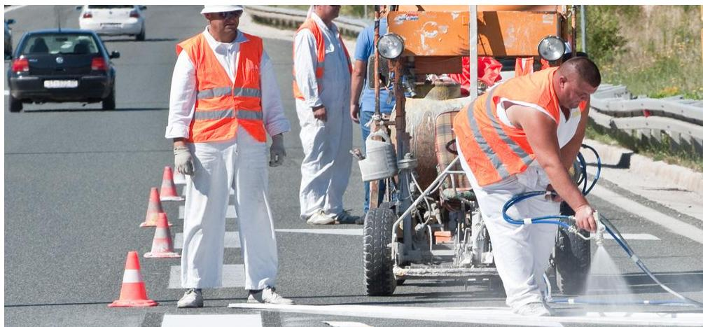
**Slika 5.** Održavanje ceste - Isrtavanje horizontalne signalizacije na cesti DC 1/17 rotor Podi Dugopolje[16]
