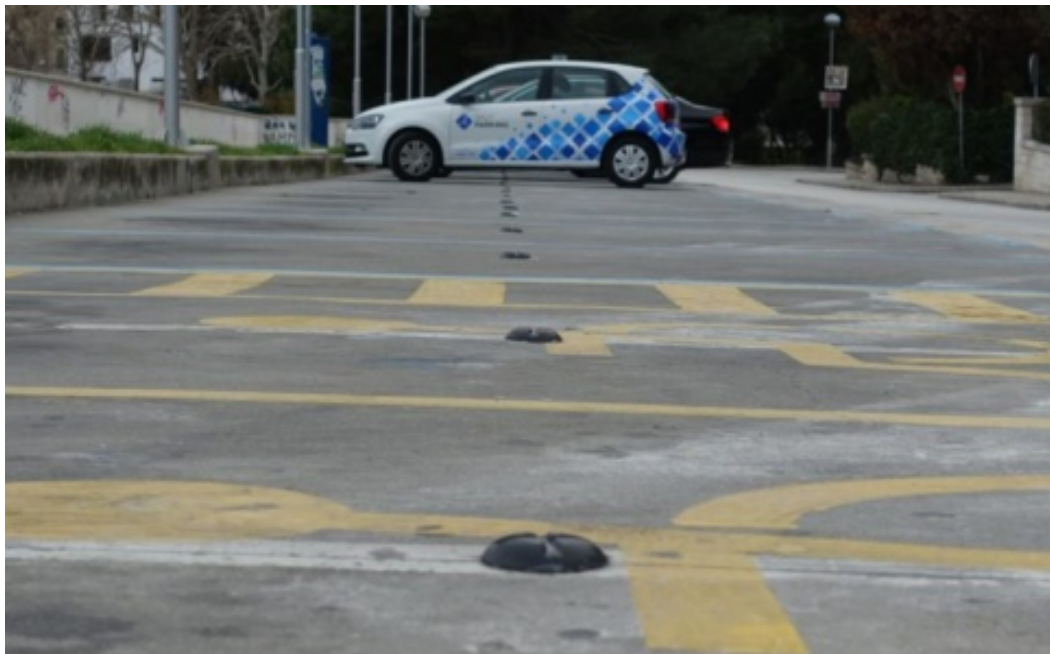
Slika 6.7. Parkirališni senzori ugrađeni u gradu Splitu
