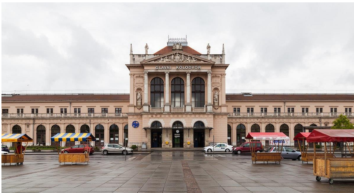
Slika 1: Kolodvorska grada Zagreb Glavnog kolodvora (sjeverni ulaz)
