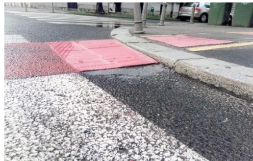
Slika 6.5. Rampe za udobniji prijelaz bicikla preko rubnjaka
