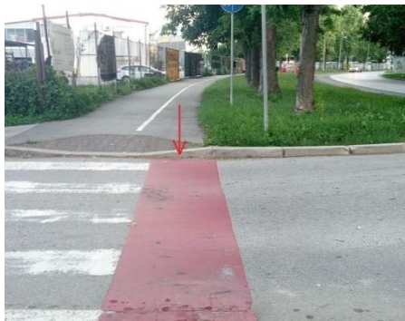
Slika 5.12. Princip mjerenja visine rubnjaka
