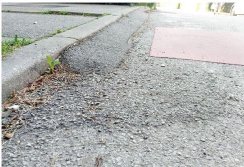
Slika 6.5. Rampe za udobniji prijelaz bicikla preko rubnjaka
