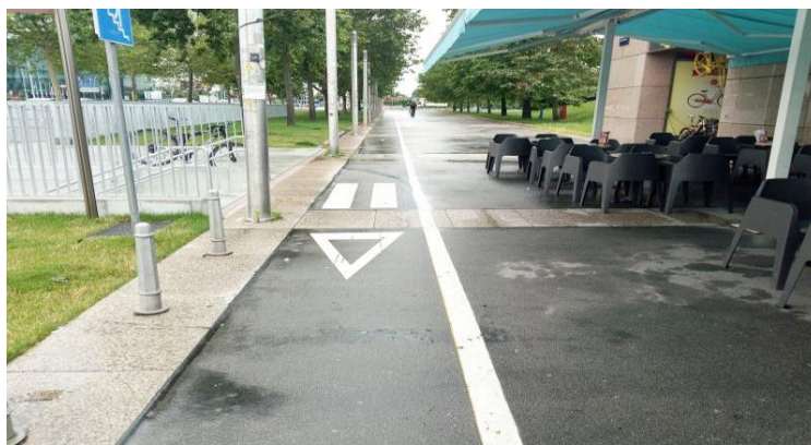
Slika 6.6. Mogući način vođenja biciklističke staze u zoni pothodnika
