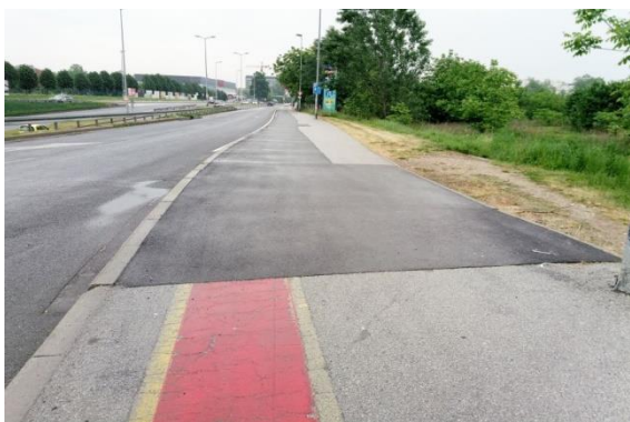
a) b) Slika 5.9. Neoznačeni dijelovi staze nakon završetka radova
