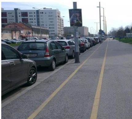
Slika 5.7. Dovoljan i nedovoljan zaštitni pojas od uzdužno parkiranih vozila
