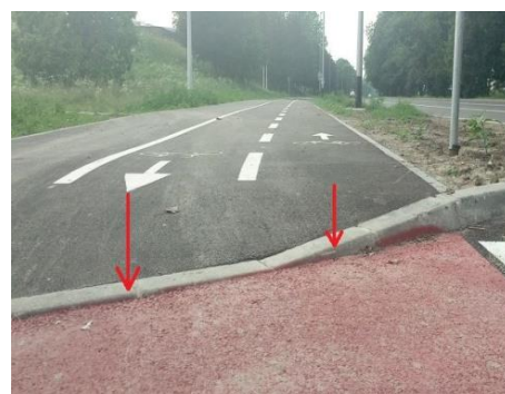
Slika 5.12. Princip mjerenja visine rubnjaka
