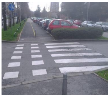
Slika 5.3. Primjeri nepravilno označenih prijelaza
