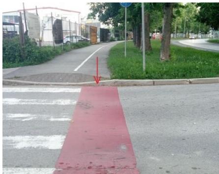
Slika 5.12. Princip mjerenja visine rubnjaka
