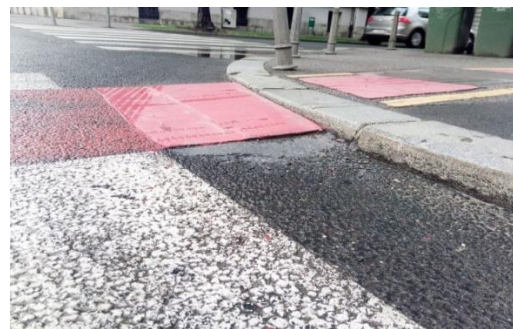
Slika 6.5. Rampe za udobniji prijelaz bicikla preko rubnjaka
