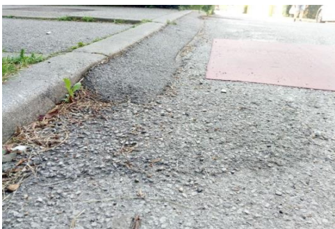
Slika 6.5. Rampe za udobniji prijelaz bicikla preko rubnjaka
