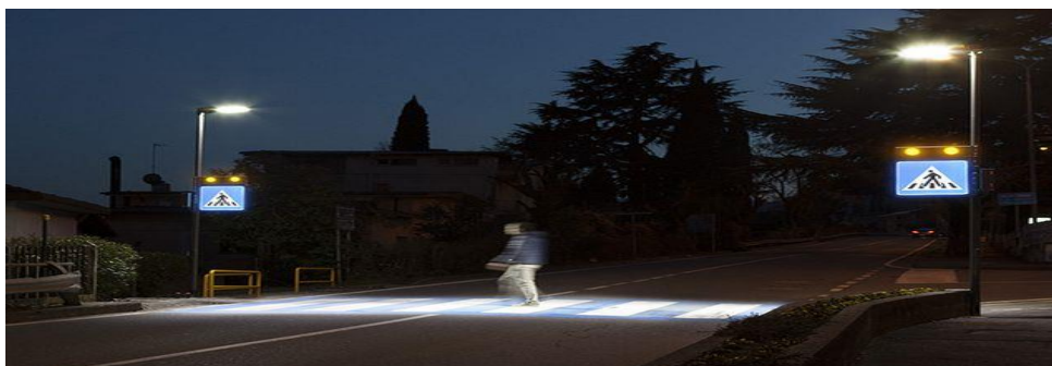
Slika 6.1. Prijelaz s adaptivnom LED rasvjetom
