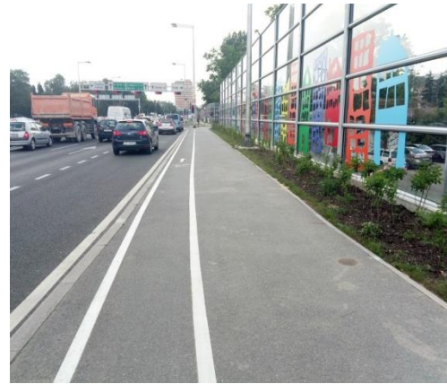
Slika 5.6. Nedovoljan zaštitni pojas od ruba kolnika na obnovljenim biciklističkim stazama
