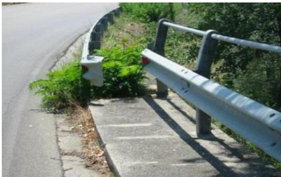
**Slika 20. Neusklađenost zaštitne ograde na mostu i uz kolnik**
