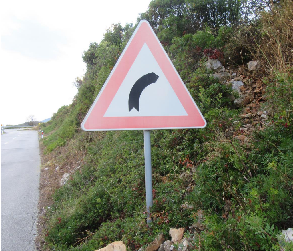
Slika 17. Prometni znak A09 – zavoј na desno, s lošim retroreflektivnim svojstvima
