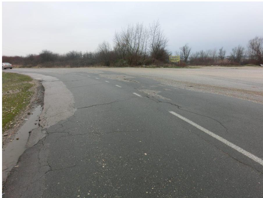
**Slika 19. Oštećen kolnik u zavoju.**
