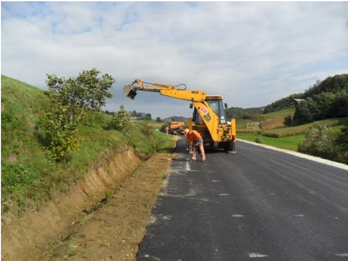
Slika 10. Radovi na uređenju odvodnje Izvor: http://www.zczz.hr/programs.html ( 4.9.2018)
