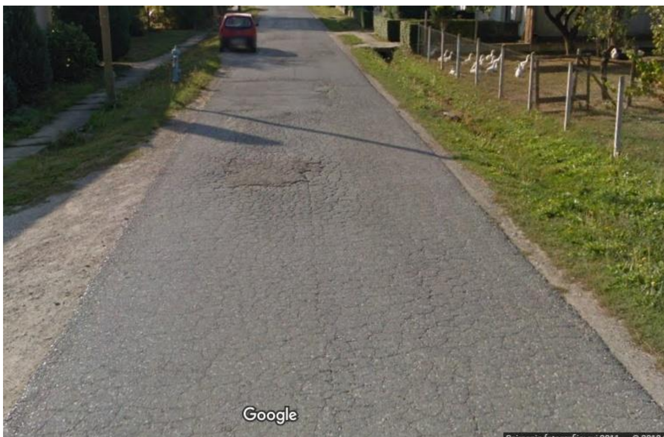
Slika 9. Dio kolnika lokalne ceste LC 26138 u naselju Karane
