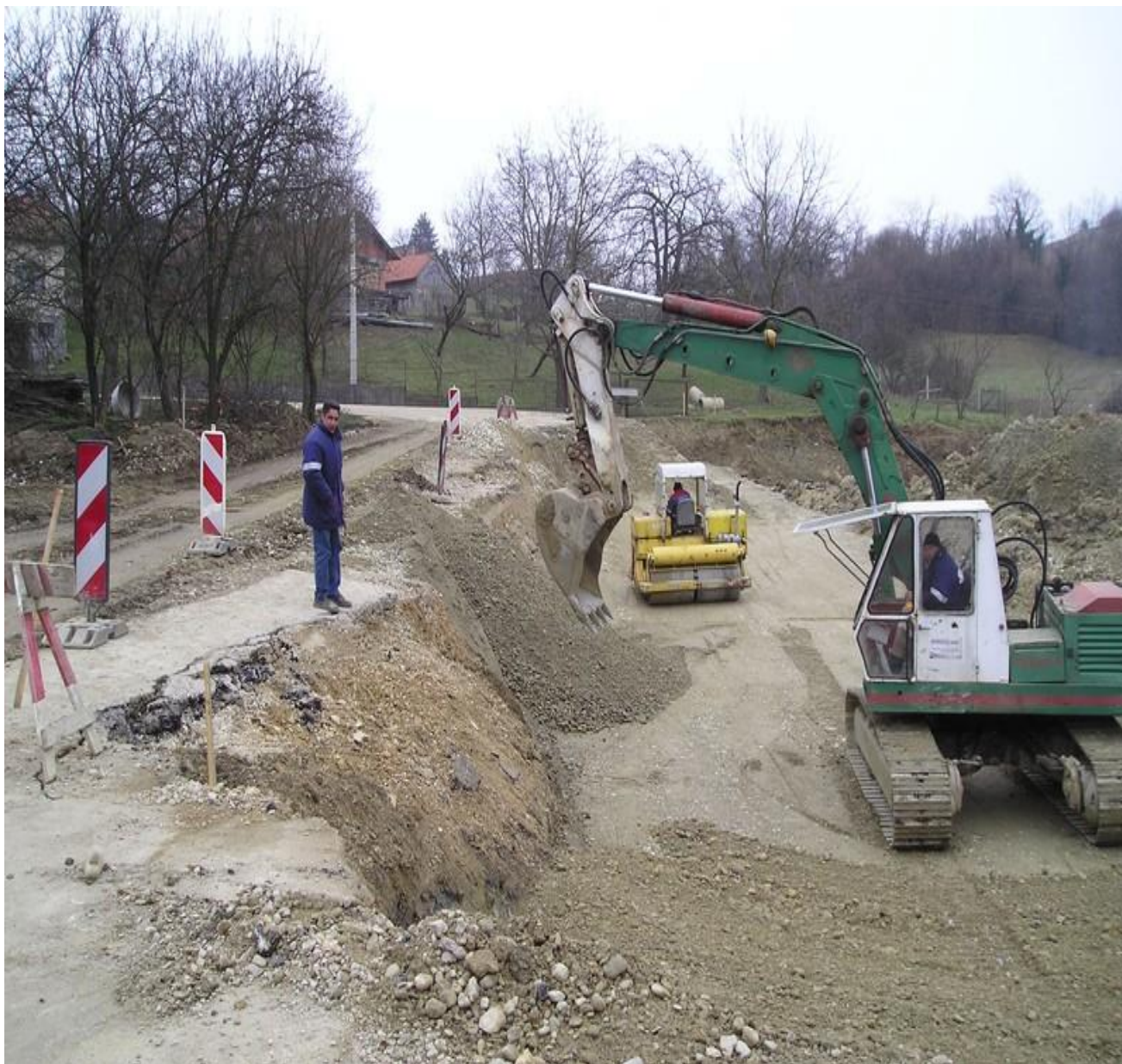
Slika 13. Sanacija klizišta u mjestu Apatovec
